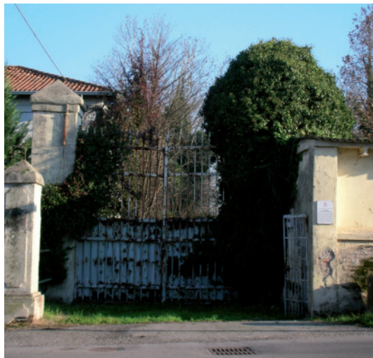
14 - Ex area militare di San Nicolò, particolare di uno degli ingressi
