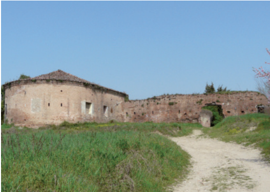
5 - Lunetta Fossamana, particolare del fronte di gola
