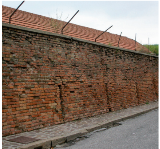
16 - Particolare del tratto di mura ancora esistente lungo via Luca Fancelli
