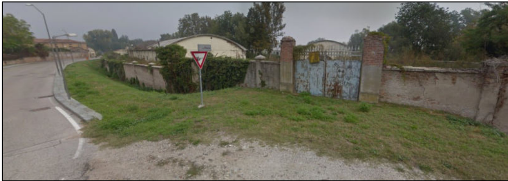
Muro di recinzione lato Vicolo Maestro
