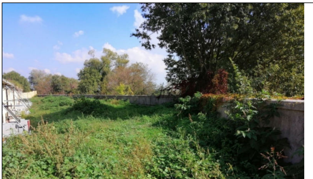
Muro di protezione lato Mincio
