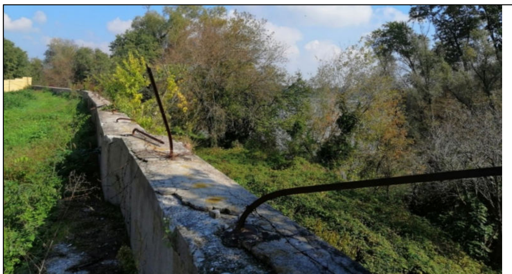
Muro di protezione lato Mincio
