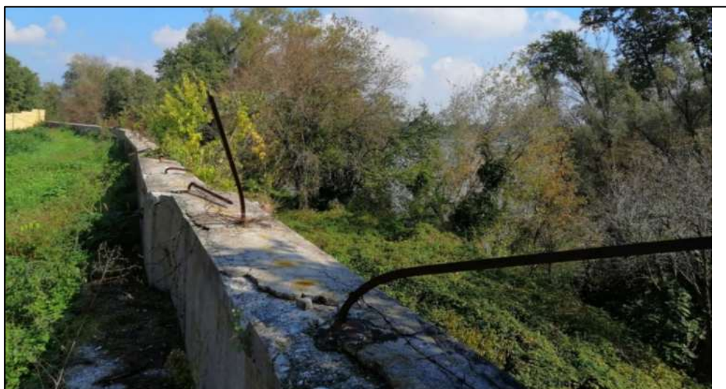
Muro di protezione lato Mincio
