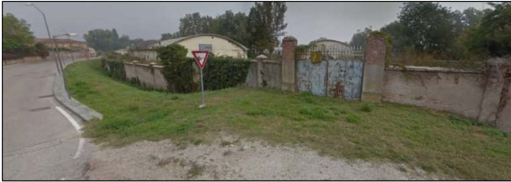
Muro di recinzione lato Vicolo Maestro
