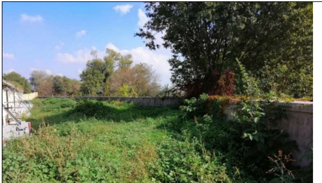
Muro di protezione lato Mincio
