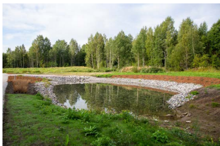
Nuovo stagno di ritenzione delle acque piovane. Area di Länsi-Hennala.
