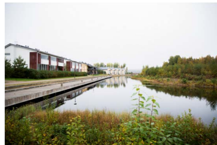
Stagno di ritenzione e gestione delle acque piovane. Il lago viene ora utilizzato attivamente per nuotare.
