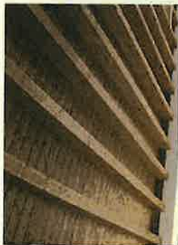
FIG. n. 2 - Finiture interne - soffitto in legno lamellare - copertura
